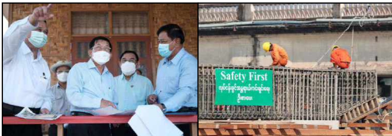
ကမြောကင်းတံတားတည်ဆောက်မှုစီမံကိန်းအား သွားရောက်ကြည့်ရှုစစ်ဆေးနေမှု
